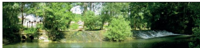
Ouvrage « déversoir » en travers de l'Ornain à Menaucourt, à l'étude pour être supprimé
